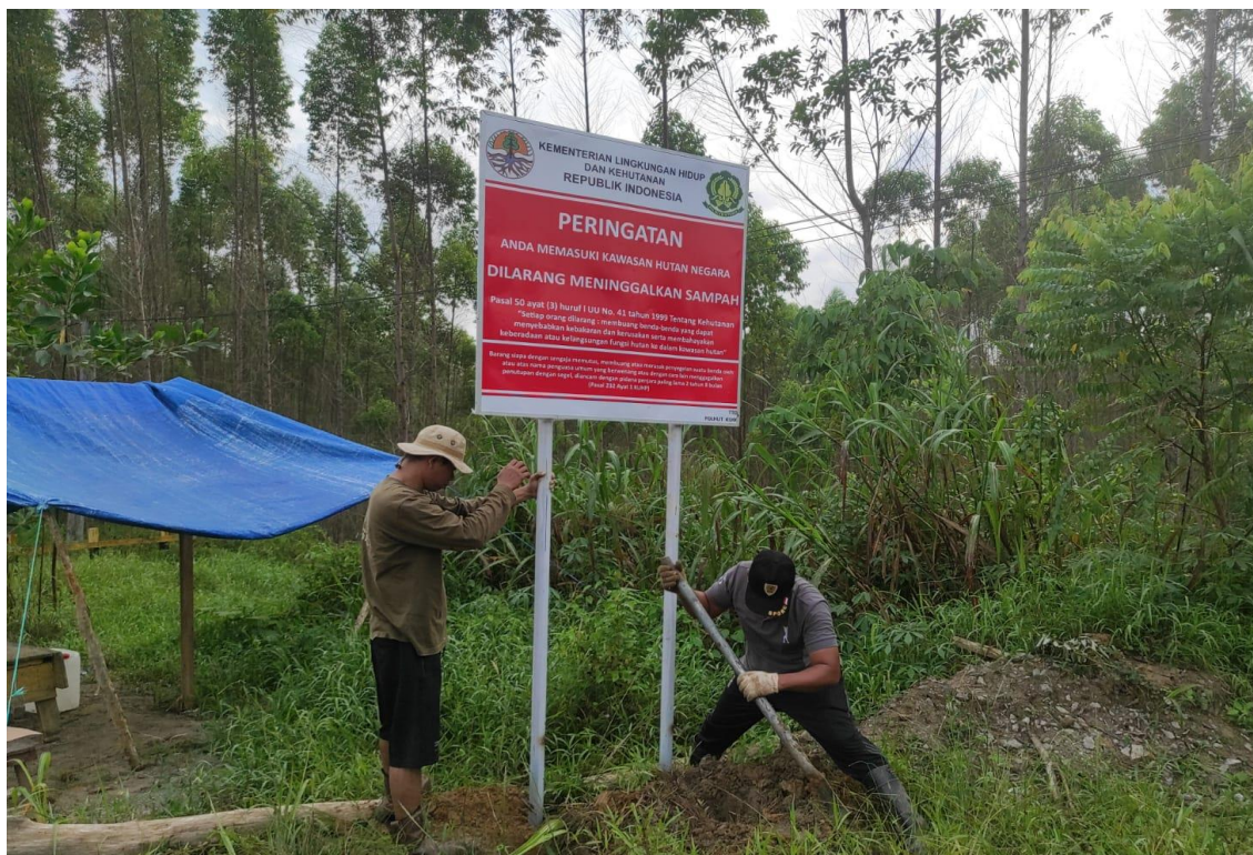
Gambar 4. Pemasangan Plang Larangan di area IKN
