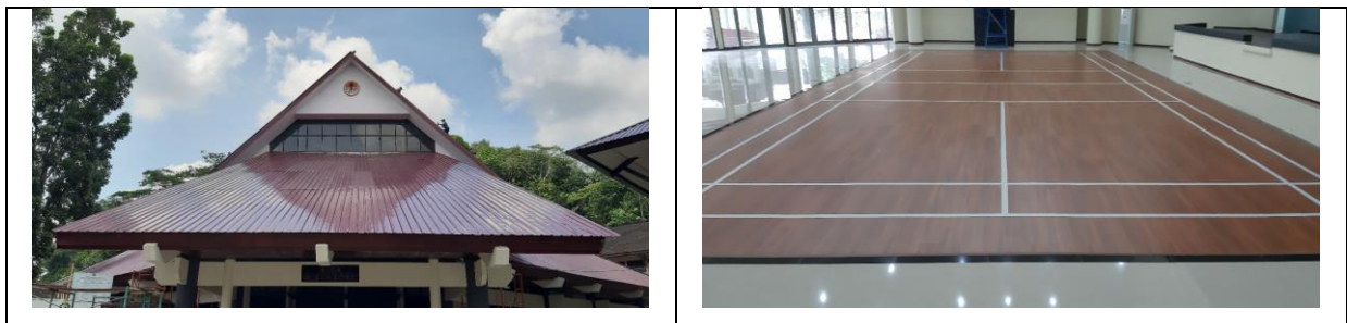
Gambar 19. Renovasi Aula Tahap II dan Atap Aula
